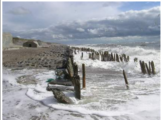
Rester af tysk kystsikring foran batteriet
