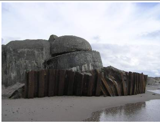
Batteriets ildlederbunker, Regelbau 636a, med rester af tysk kystsikring foran
