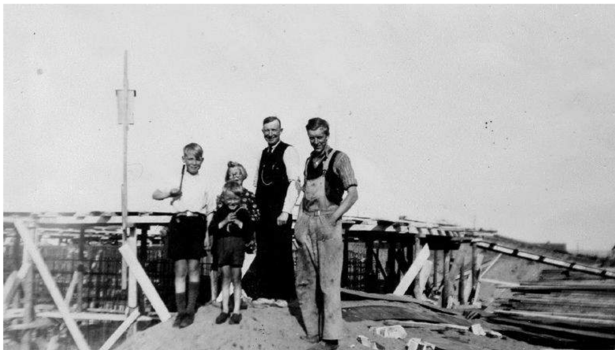
Opbygningen af den indvendige forskalling og jernfletningen i bunkerens vægge er nu gået i gang. Bunkerens danske naboer tager arbejdet i øjesyn.
